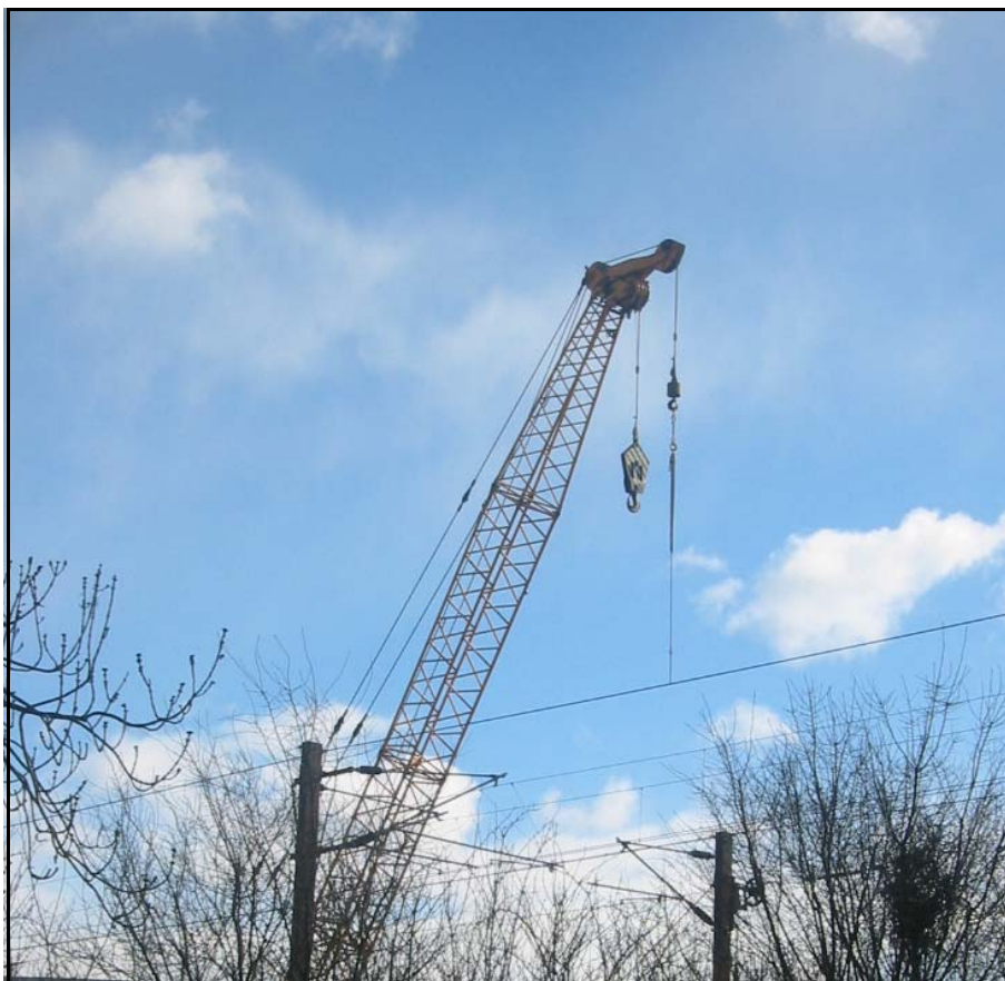
Der bygges på Vigerslev station
